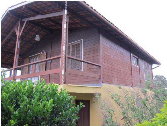
Foto 37: Pavimento Superior em madeira
