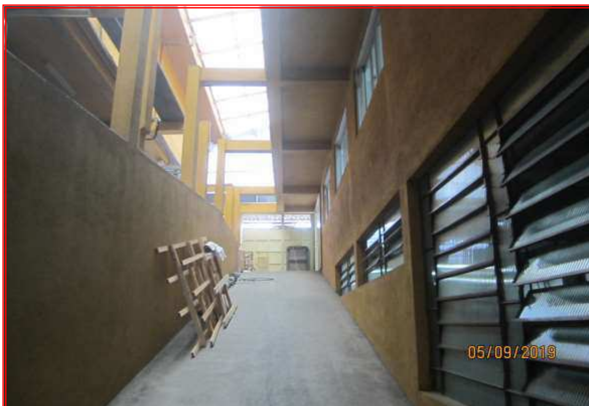
Foto nº 14: Vista da rampa de circulação.
