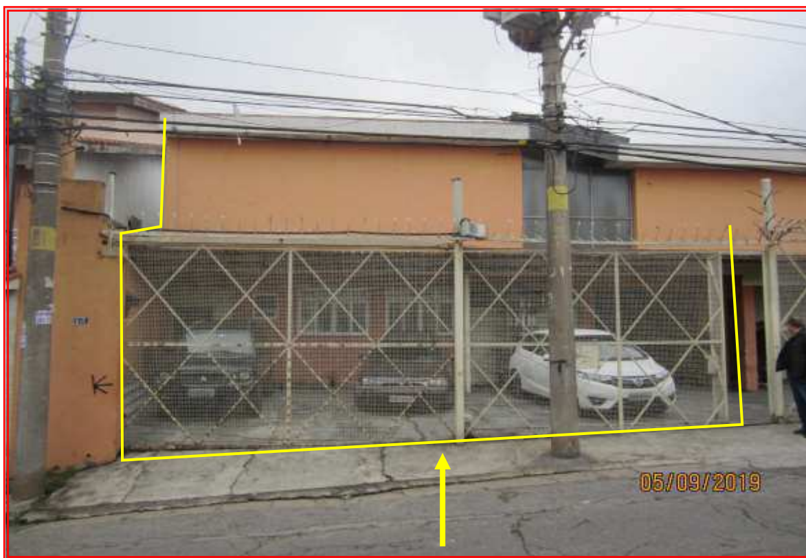
Foto nº 02: Vista geral da fachada do imóvel avaliando.
