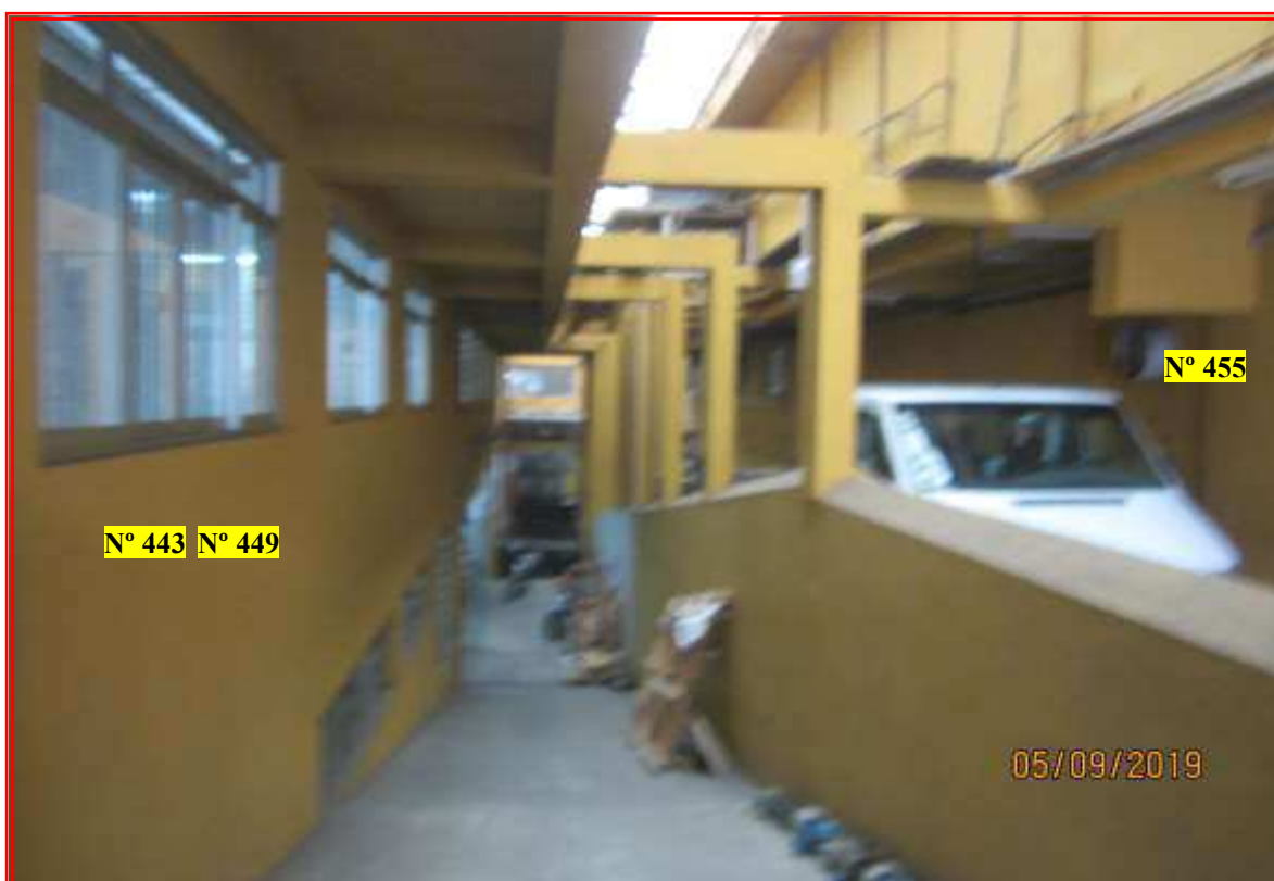
Foto nº 03: Vista interna do imóvel, com detalhe para o corredor de divisa entre o imóvel avaliando nº 443/449 e 455.
