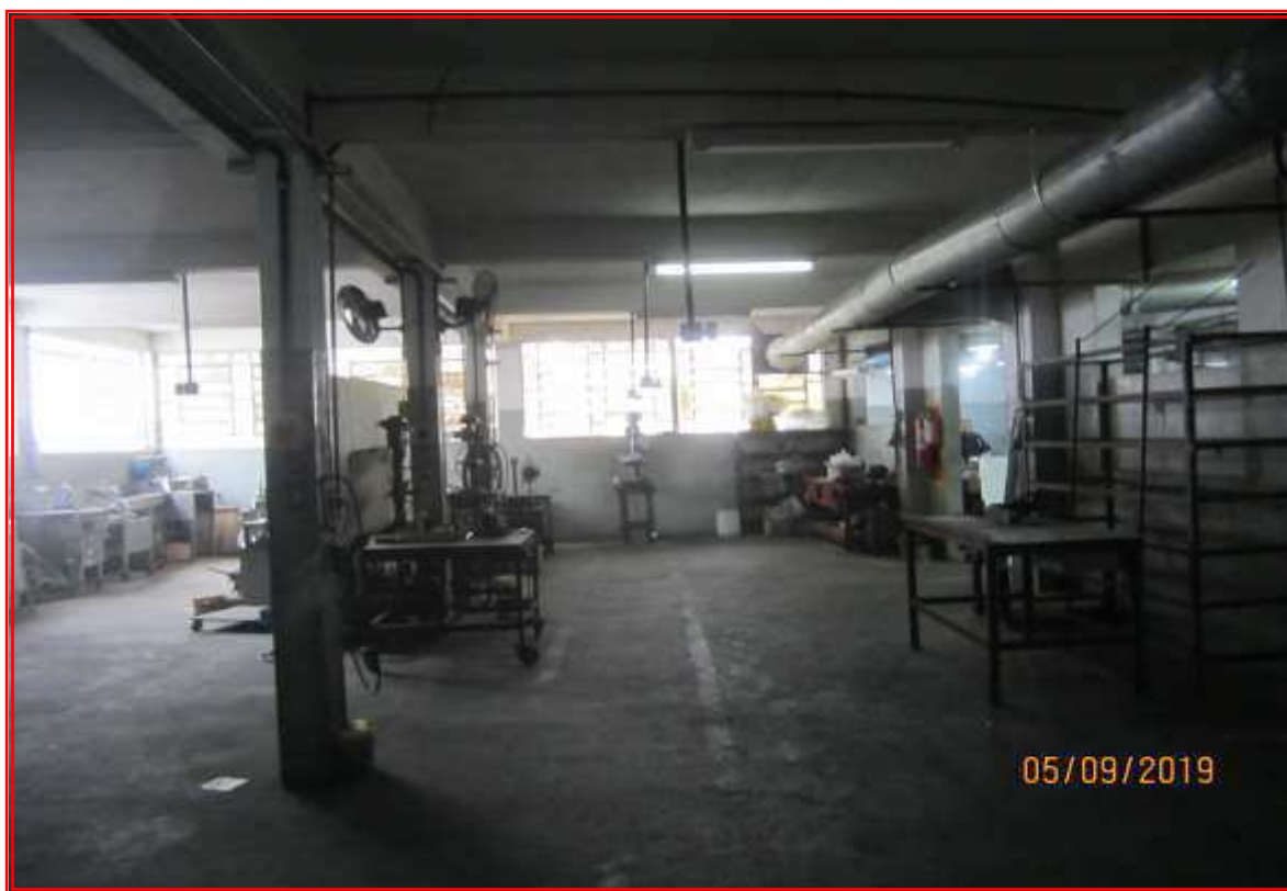
Foto nº 10: Vista parcial do salão 1º subsolo.
