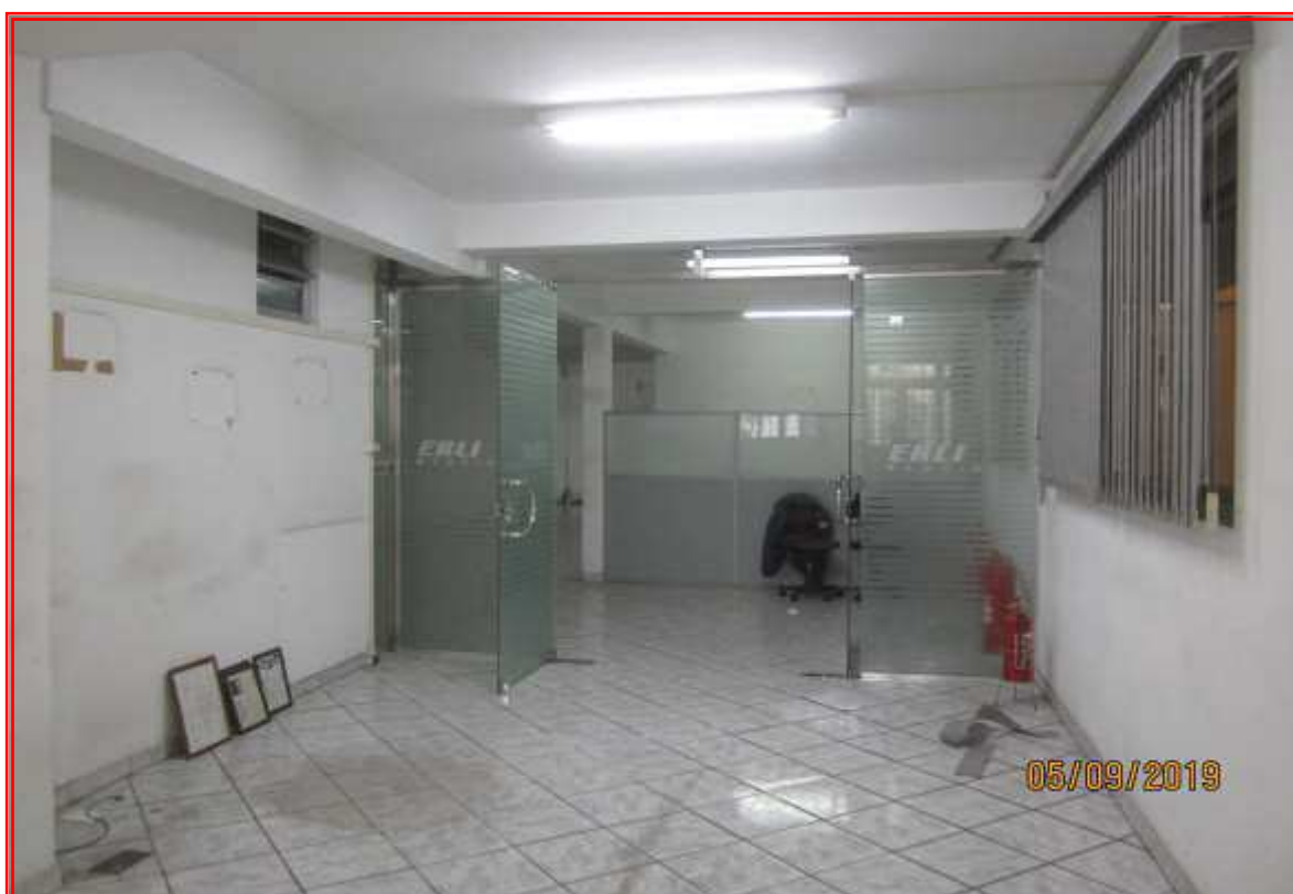
Foto nº 04: Vista parcial da recepção (Pavimento Térreo).
