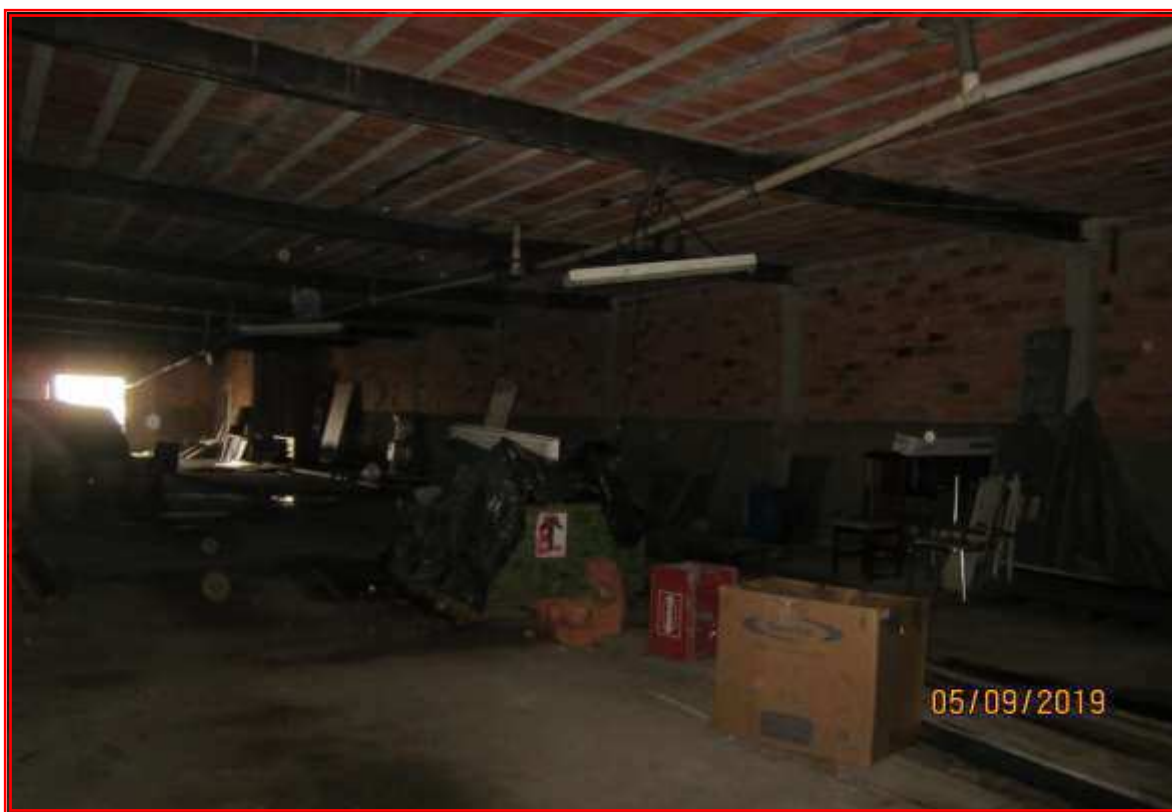
Foto nº 15: Vista parcial do salão (Pavimento Superior).
