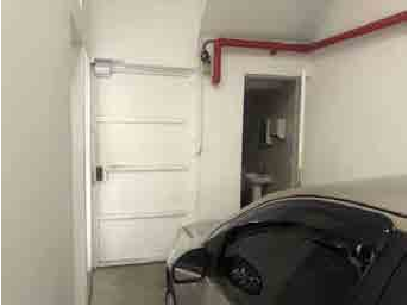
Foto 8: Piso térreo – acesso ao WC e hall de entrada.
