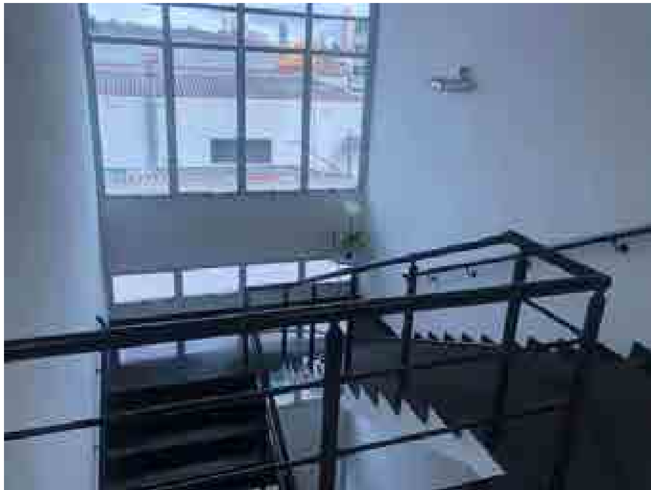
Foto 26: 3º andar – Escada de acesso ao 2º piso.
