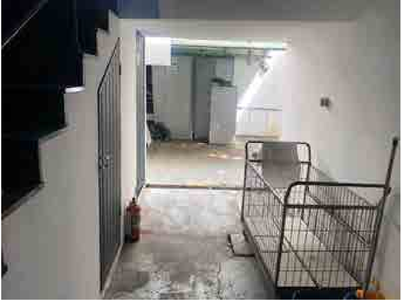
Foto 4: Piso térreo – acesso ao quintal e edícula.
