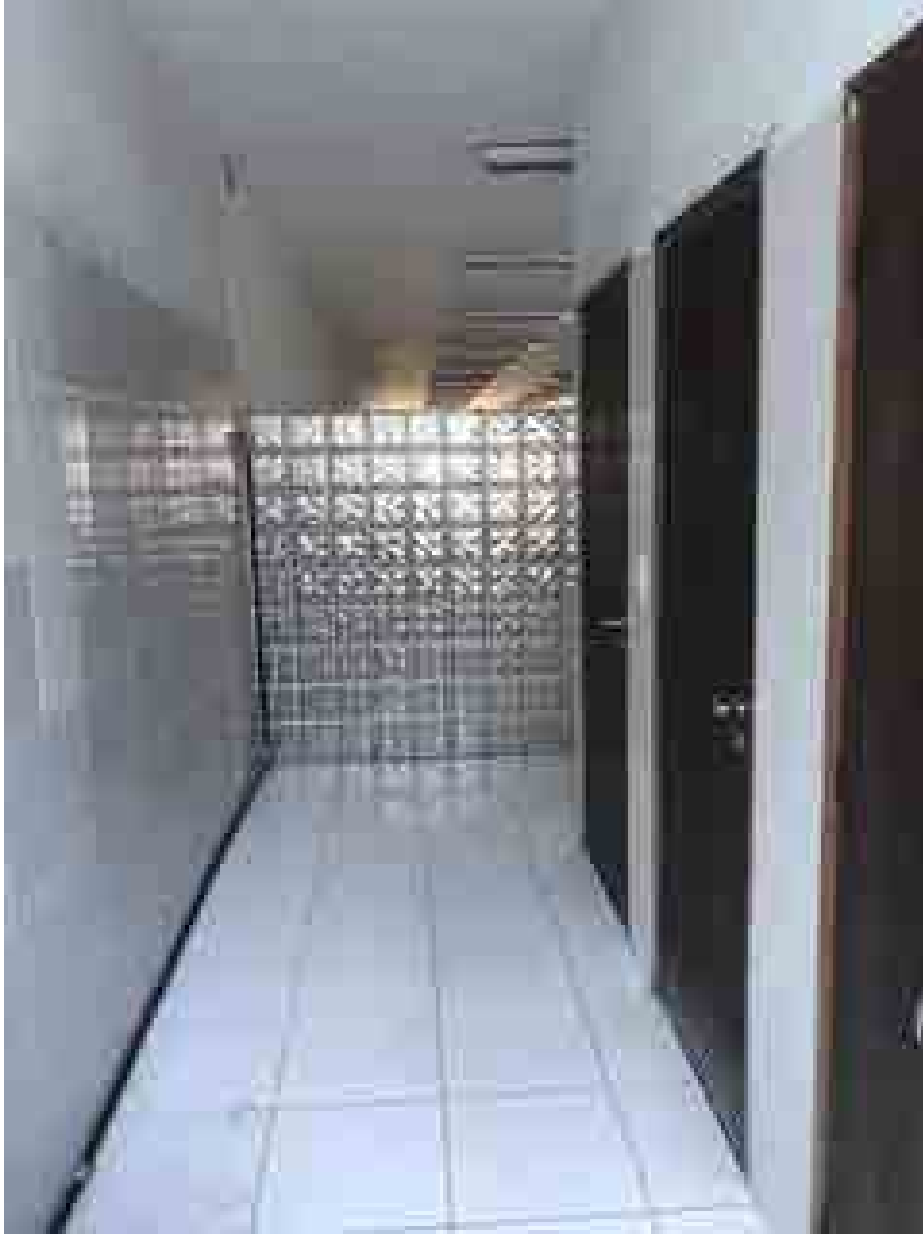
Foto 18: 1º andar – WCs.
