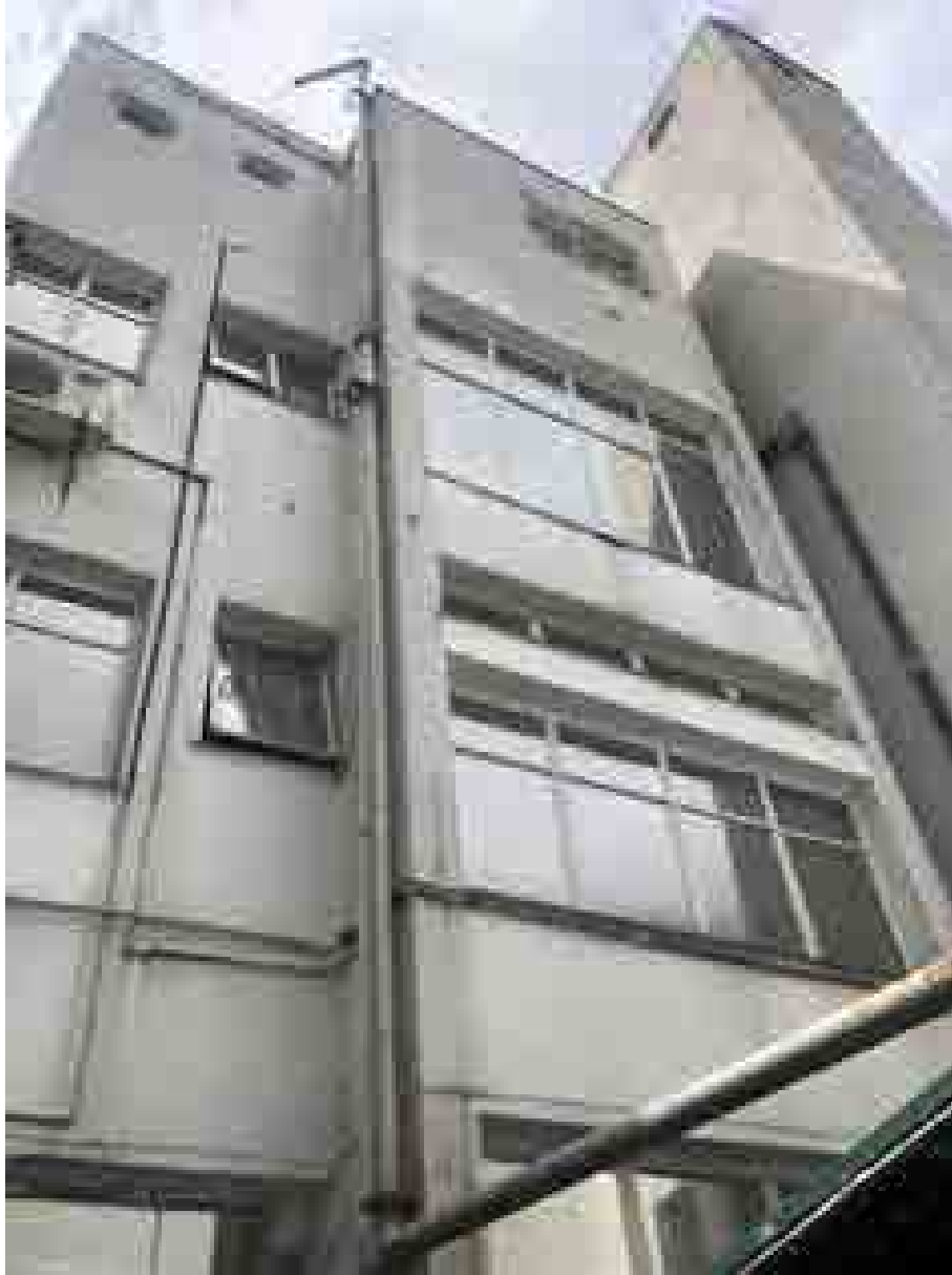
Foto 5: Piso térreo – fachada fundos.
