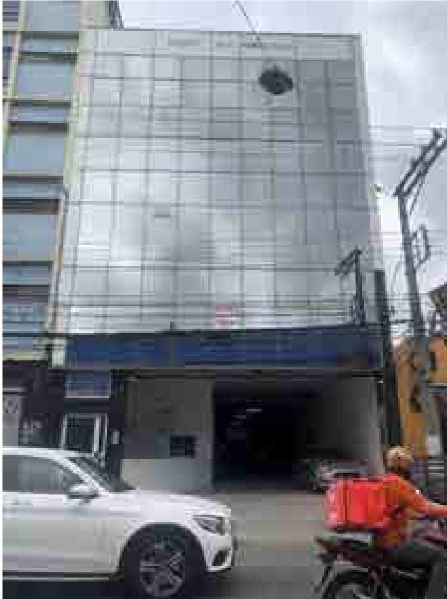
Foto 1: Vista da fachada do imóvel avaliando.
