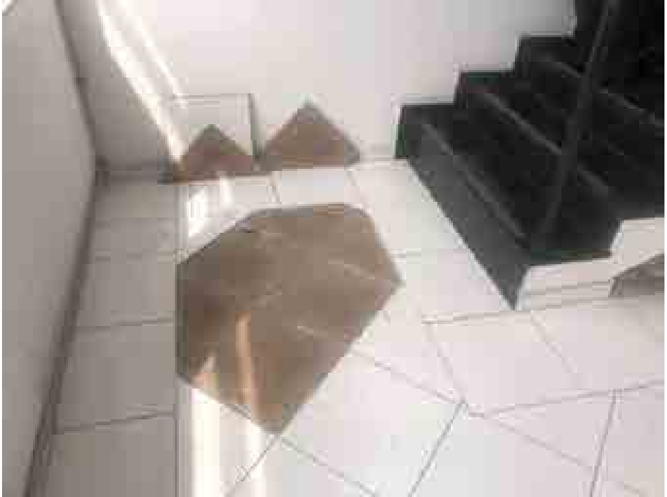
Foto 15: 1º andar – acesso à escada.
