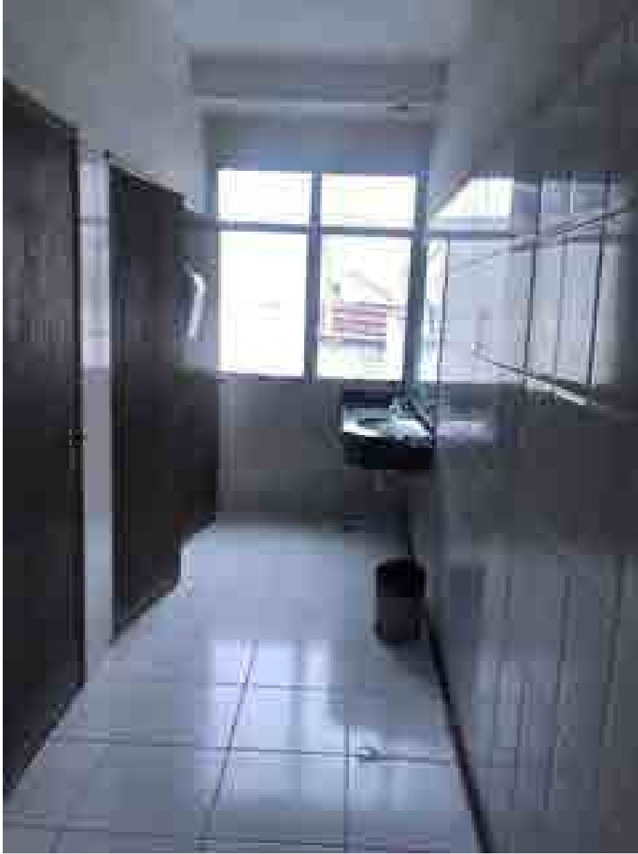
Foto 17: 1º andar – WCs.
