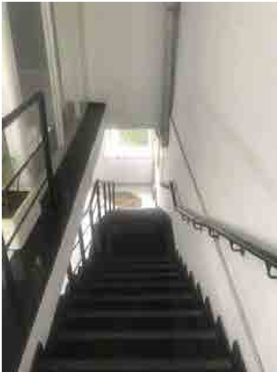
Foto 20: 2º andar – escada de acesso ao 1º piso.
