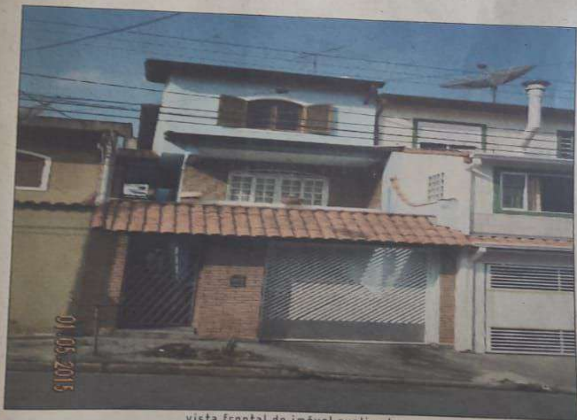
vista frontal do imóvel avaliando
