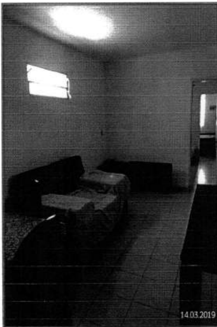
Foto nº 08: Vista parcial da sala de estar. Aos fundos observa-se a parede de subdivisão que originou o dormitório 01.
