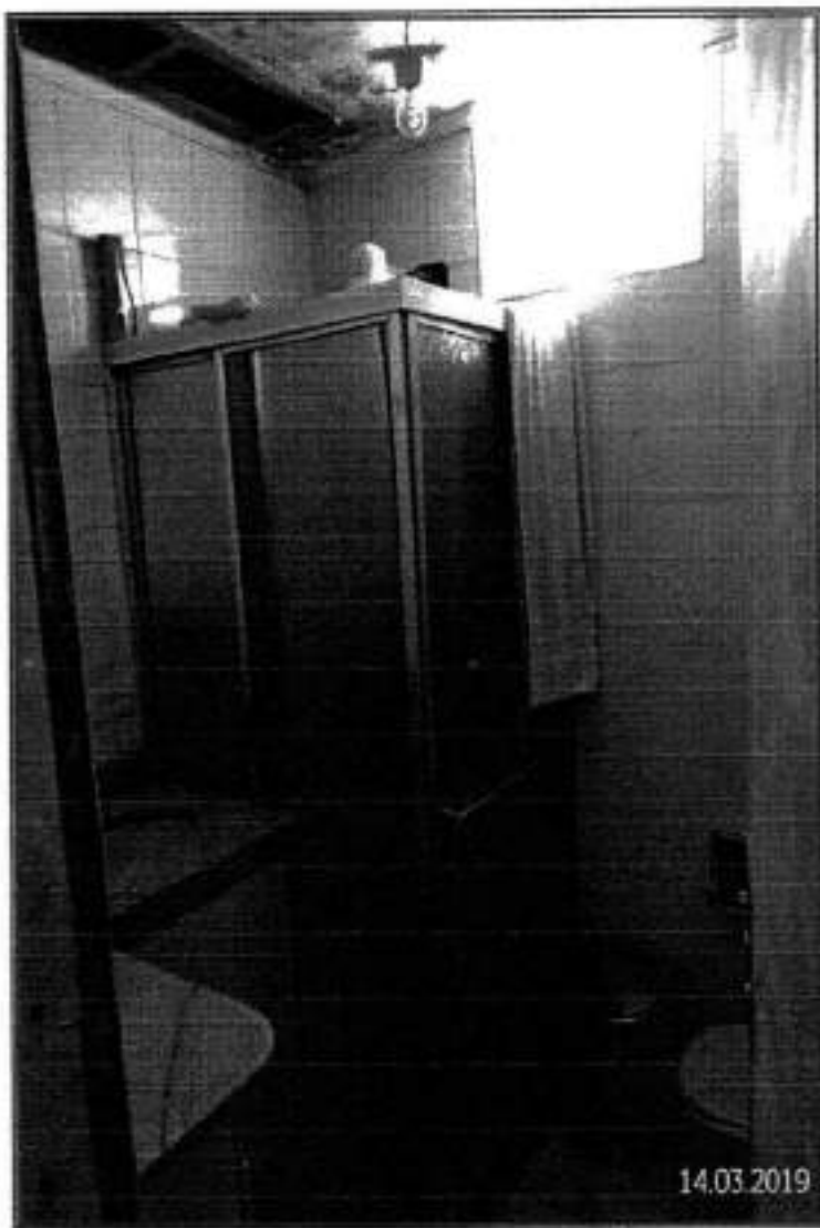
Foto nº 09: Vista parcial do banheiro.
