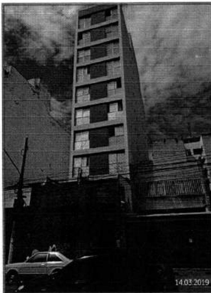
Foto: Vista geral da fachada do Edifício Jacqueline onde se localiza o imóvel avaliando.
