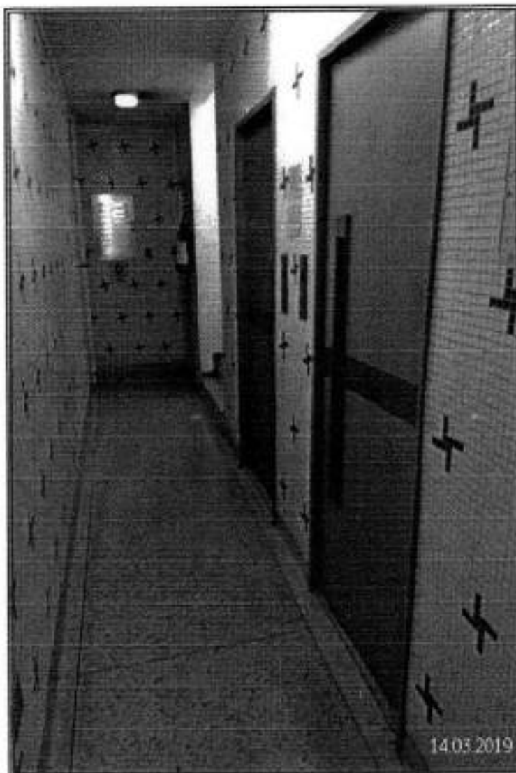
Foto nº 06: Vista parcial do hall de elevadores do pavimento térreo.
