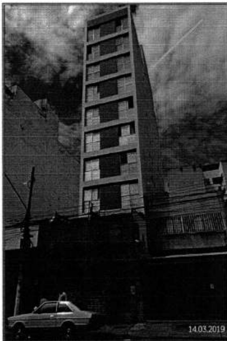
Foto nº 02: Vista geral da fachada do Edifício Jacqueline, onde se localiza o imóvel avaliando.
