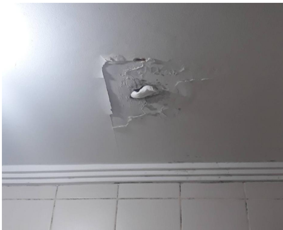
Imagem 23 a 25: Detalhe do teto do quarto, da sala e do banheiro.
