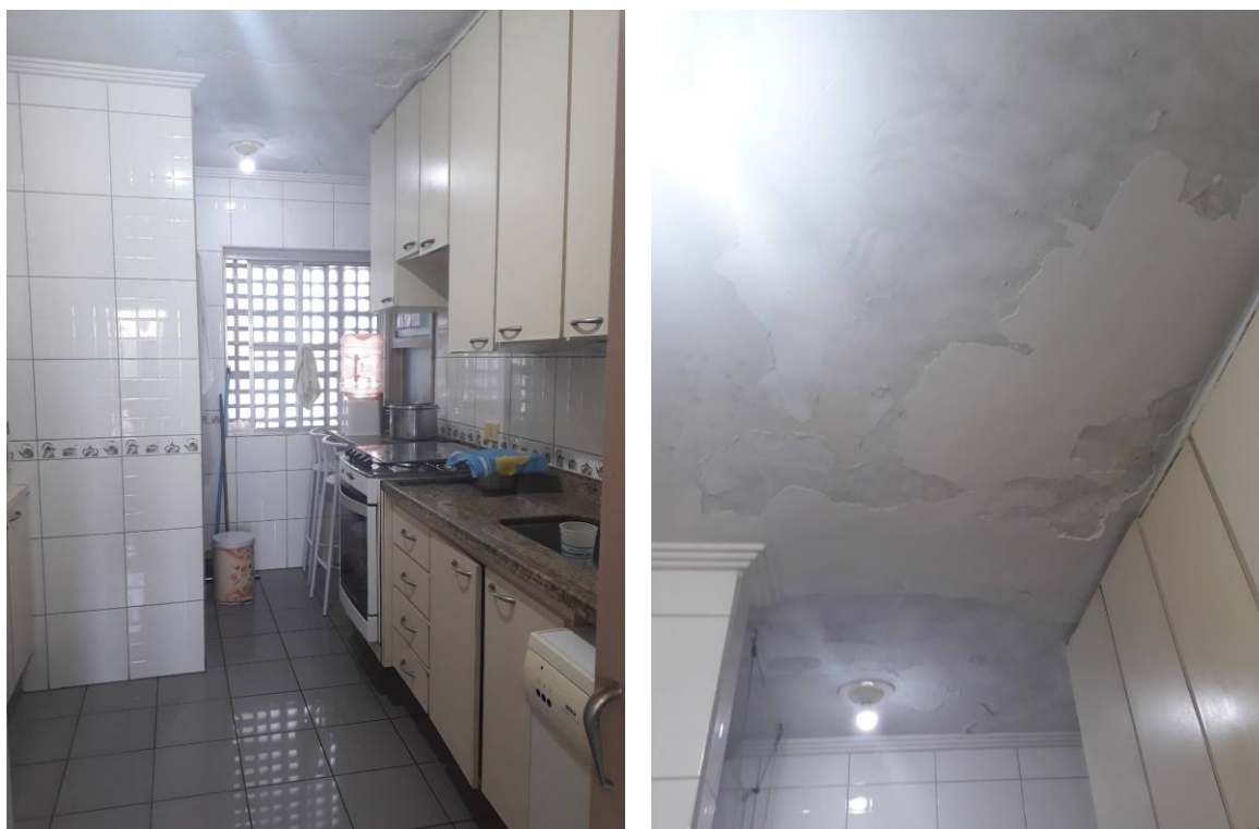
Imagem 15 e 16: Cozinha e detalhe do teto da mesma área.
