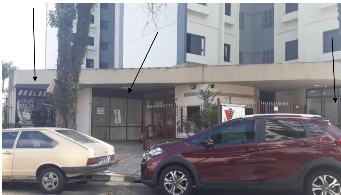
Imagem 08: Indicação das lojas da fachada ativa do Edifício.
