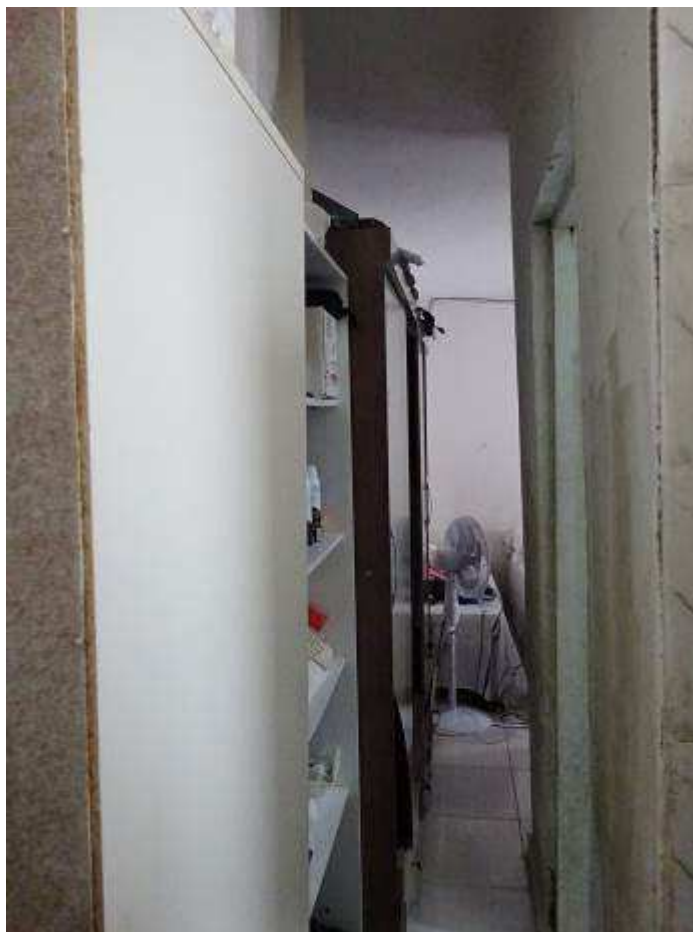
FOTO 5: Vista geral de hall de circulação do imóvel avaliando.
