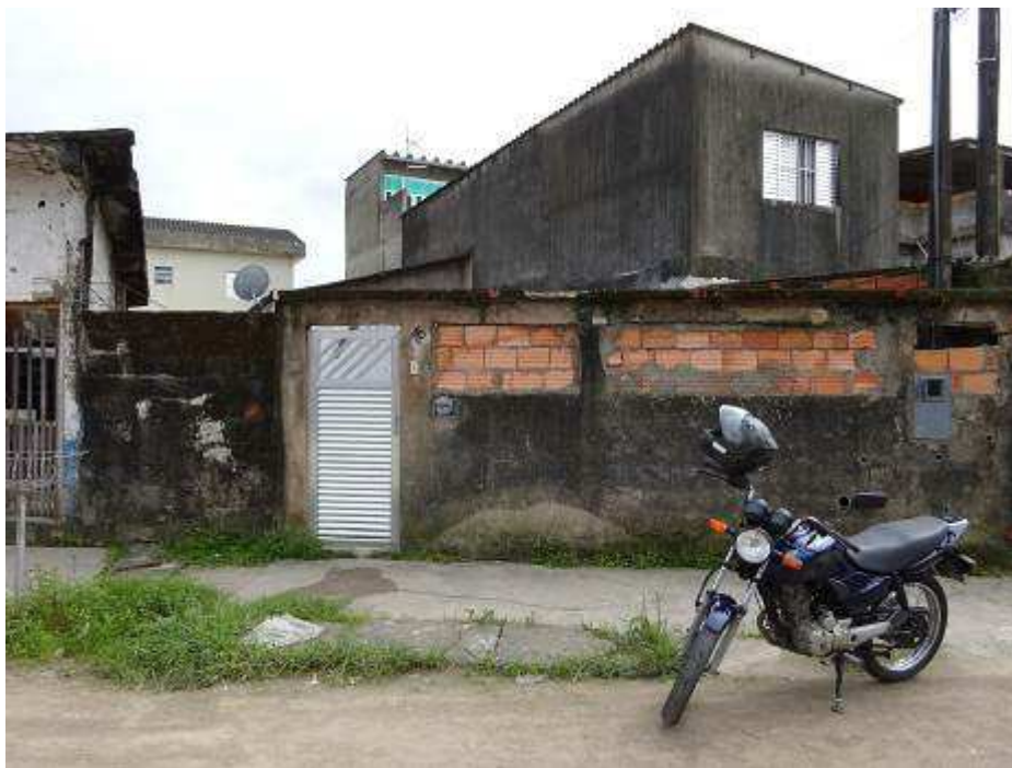
FOTO 1: Vista da fachada frontal do imóvel avaliando.
