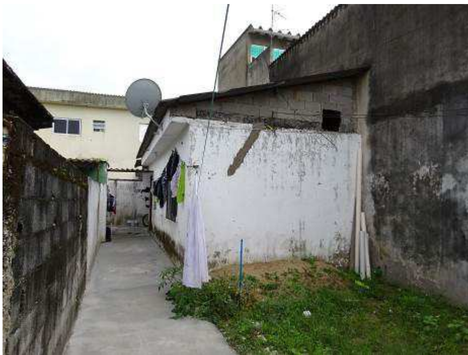
FOTO 2: Vista geral do imóvel avaliando.
