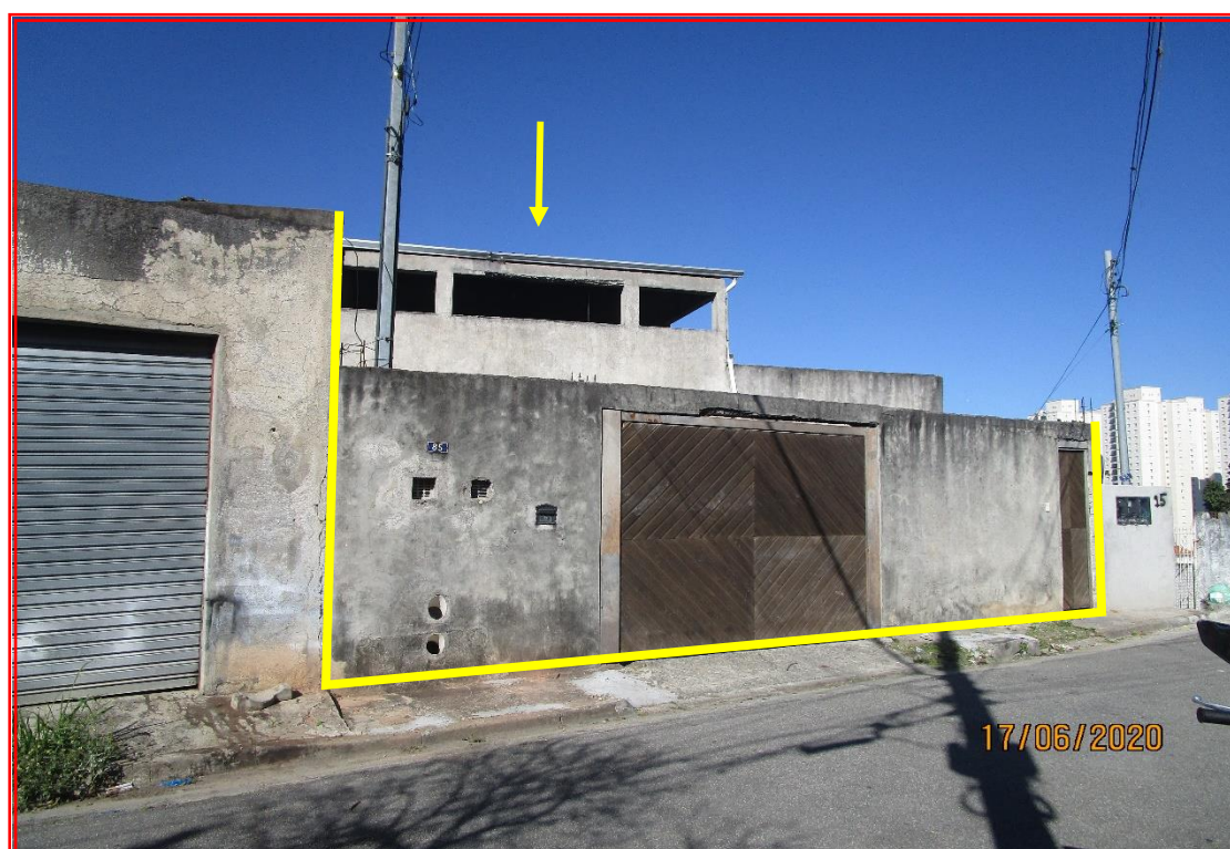
Foto: Vista geral da fachada do imóvel avaliando.
