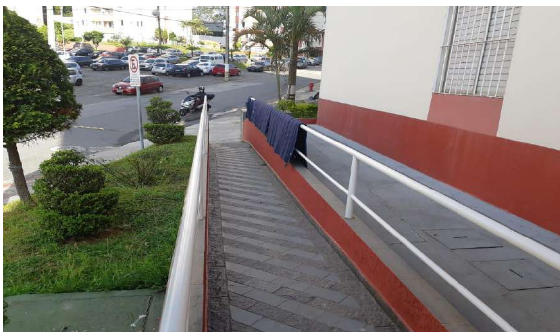
Foto 15 – Vista da entrada do hall social do bloco 01
