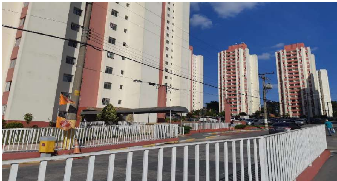
Foto 10 – Vista da entrada interna do Empreendimento
