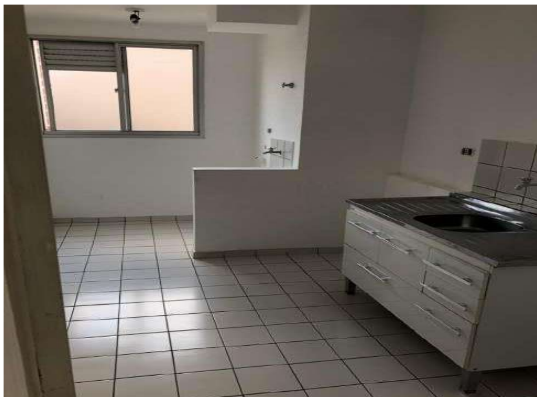
Foto 24 – Vista do Imóvel Referencial 5
