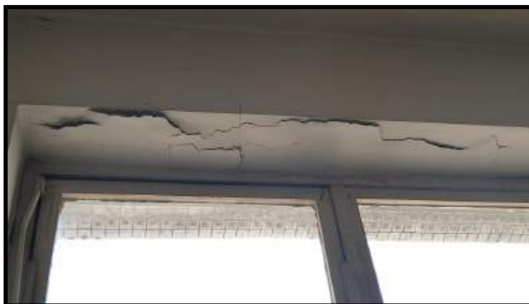
IMAGEM 34- VISTA DA JANELA DA SALA 1/ ESTADO GERAL
