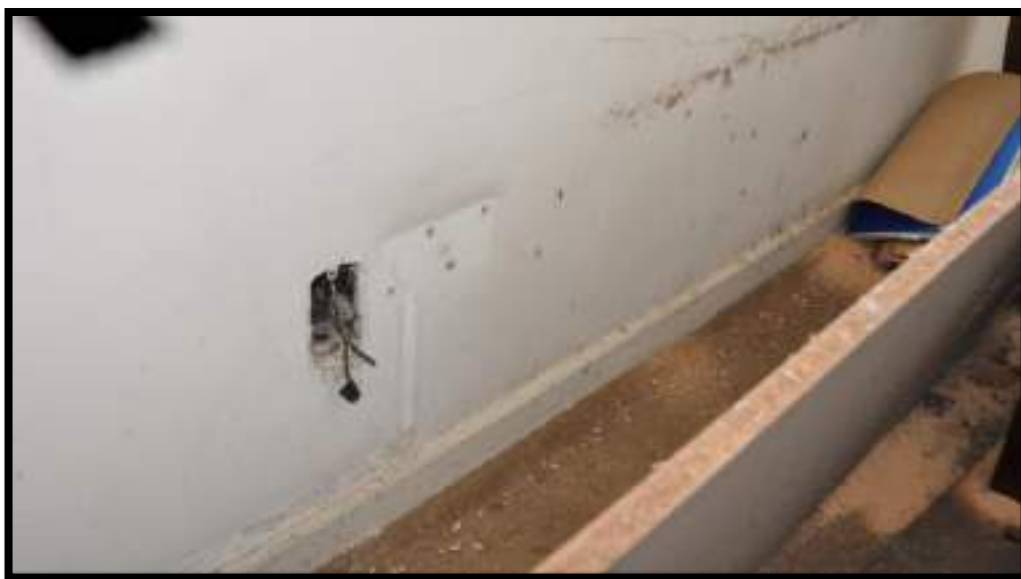
IMAGEM 53 – PISO E ACABAMENTO DA SALA 2
