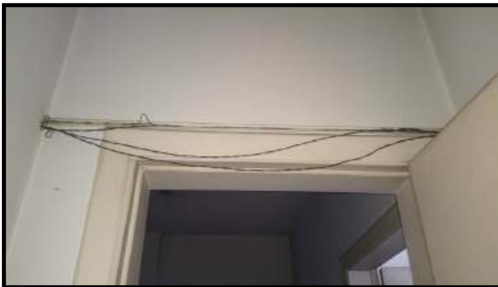
IMAGEM 21- BANHEIRO / VISTA DE DENTRO
