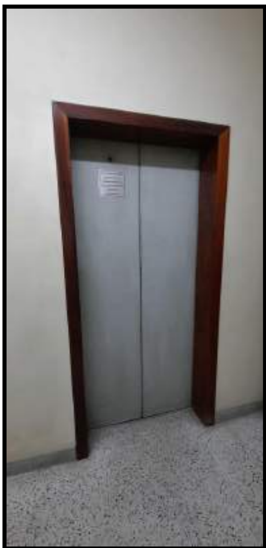
IMAGEM 60- VISTA DO EXTERIOR DO ELEVADOR
