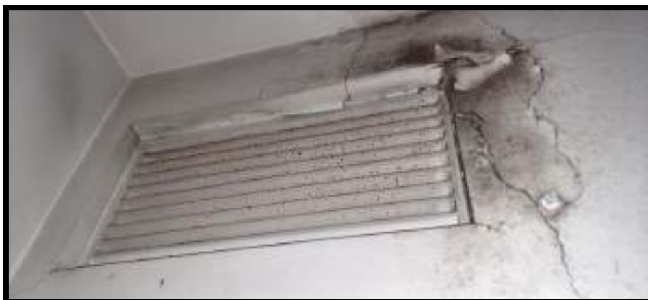
IMAGEM 23- BANHEIRO / SAÍDA DE AR
