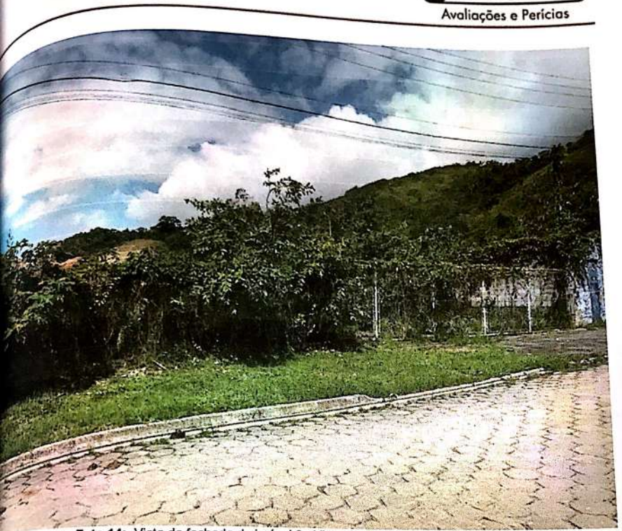
Foto 14: Vista da fachada do imóvel 2 - Vista da Rua Manoel Inácio da Costa, s/n.
