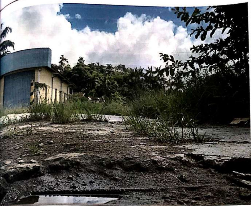
Foto 6: Vista interna do imóvel 1.
