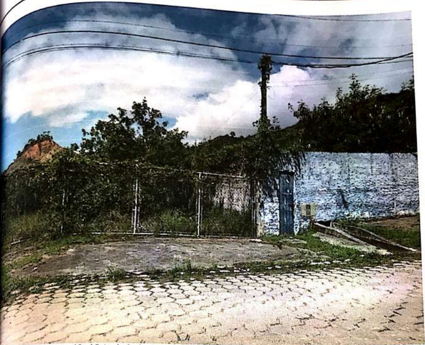
Foto 13: Vista da fachada do imóvel 2 - Vista da Rua Manoel Inácio da Costa, s/n.
