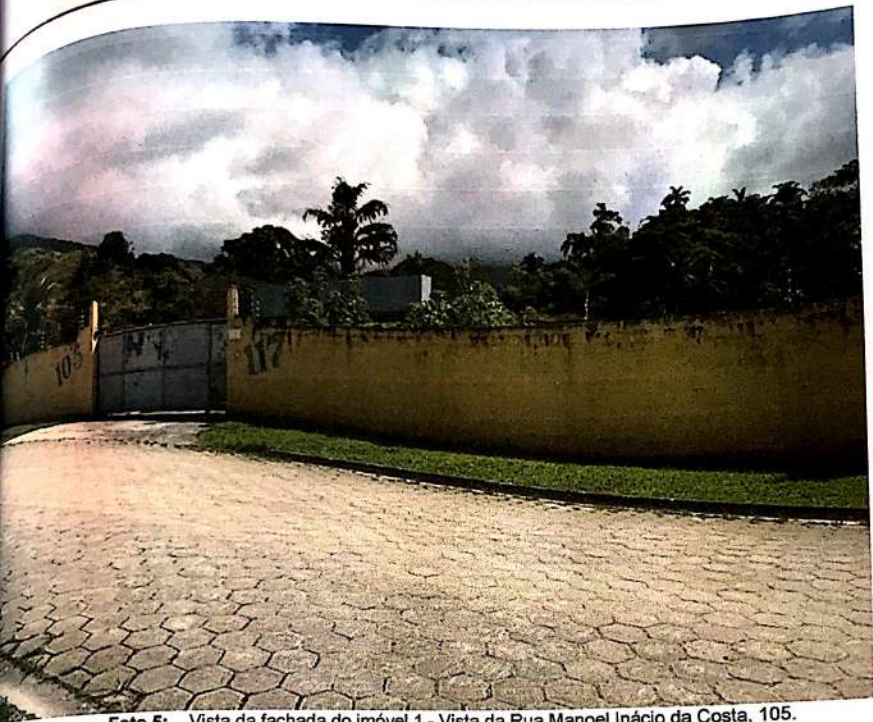
Foto 5: Vista da fachada do imóvel 1 - Vista da Rua Manoel Inácio da Costa, 105.
