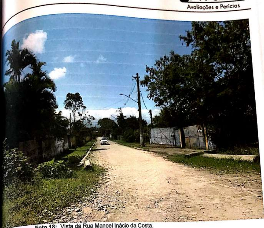
Foto 18: Vista da Rua Manoel Inácio da Costa.
