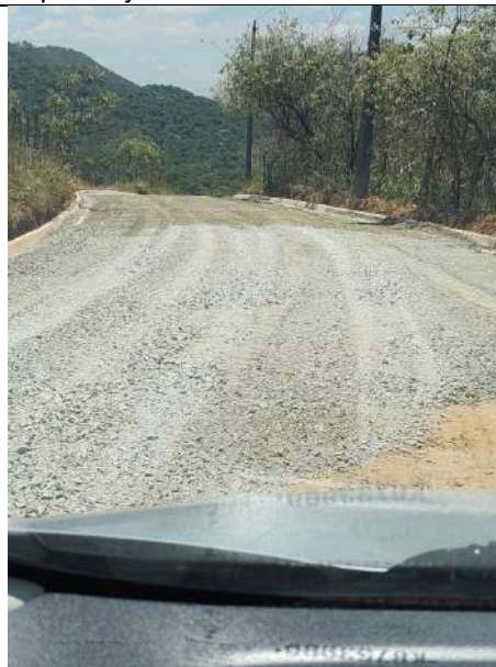
Foto 16 – Rua Nhambu trecho sendo pavimentada.
