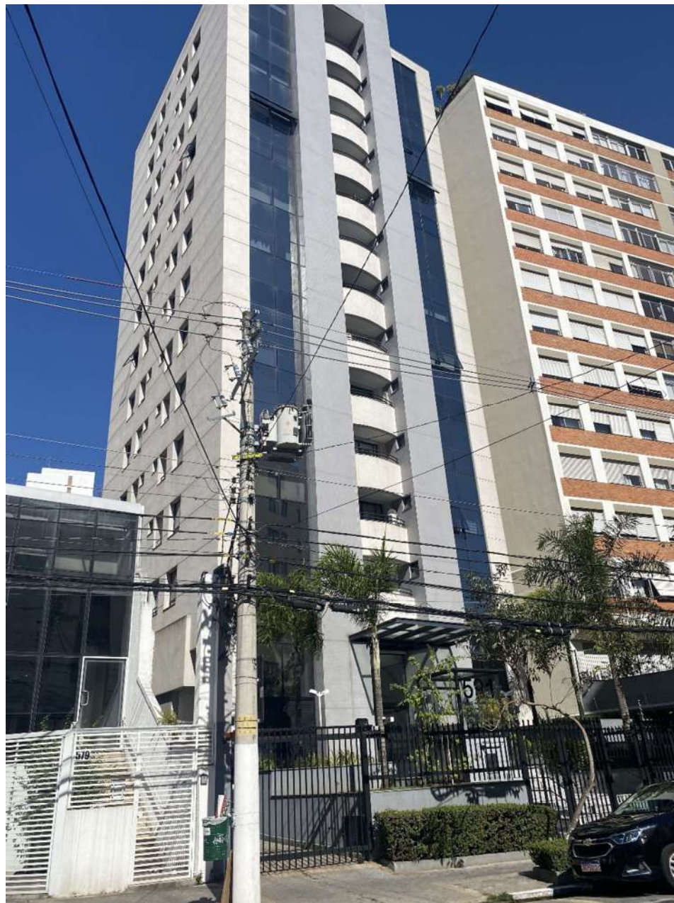
Aspectos gerais fachada
