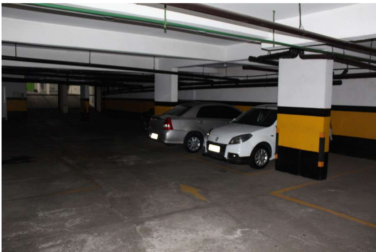
Edifício Casa de Itália – Garagem (Pavimento Subsolo)
