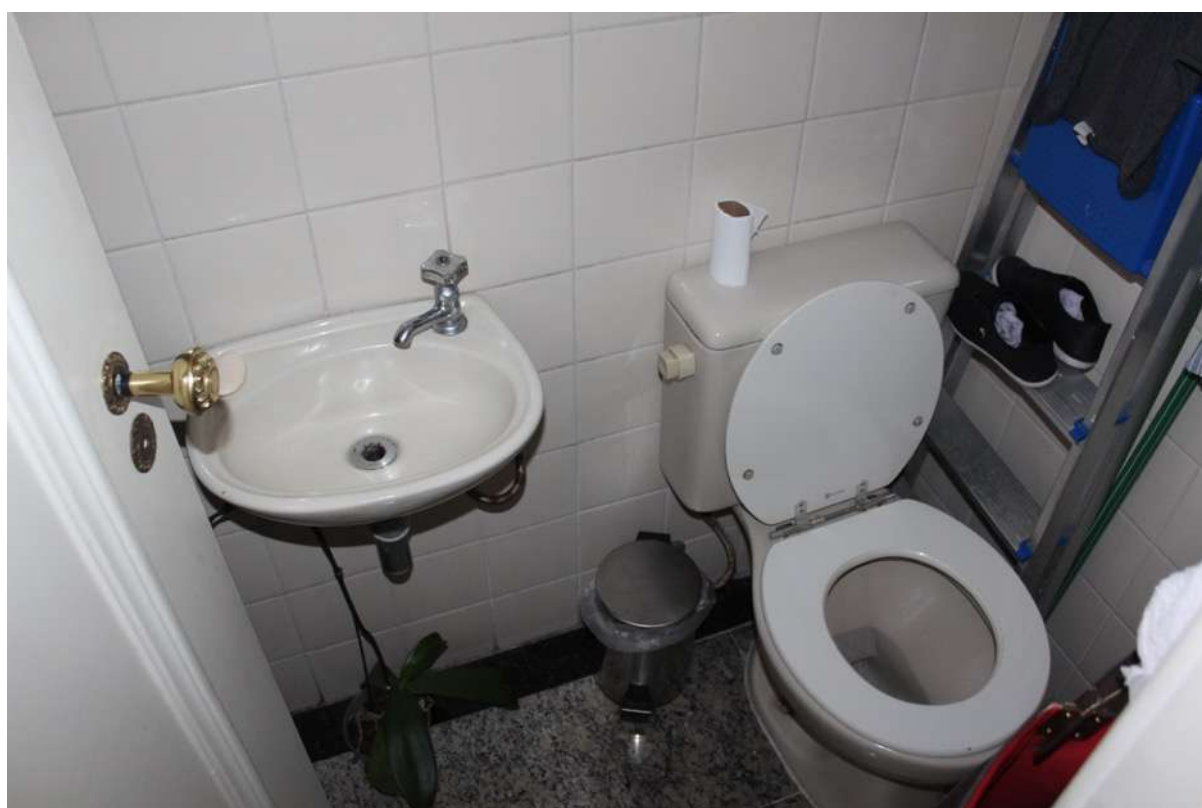
Apartamento Nº 42 – Banheiro Funcionários
