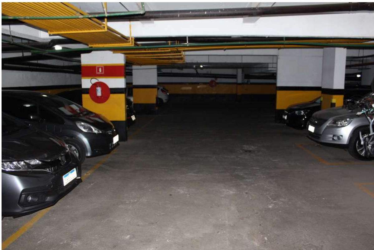
Edifício Casa de Itália – Garagem (Pavimento Subsolo)
