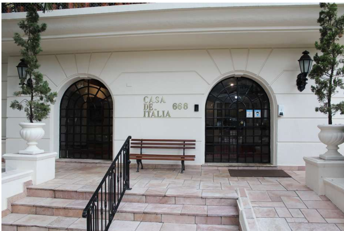
Edifício Casa de Itália – Entrada Social/Fachada
