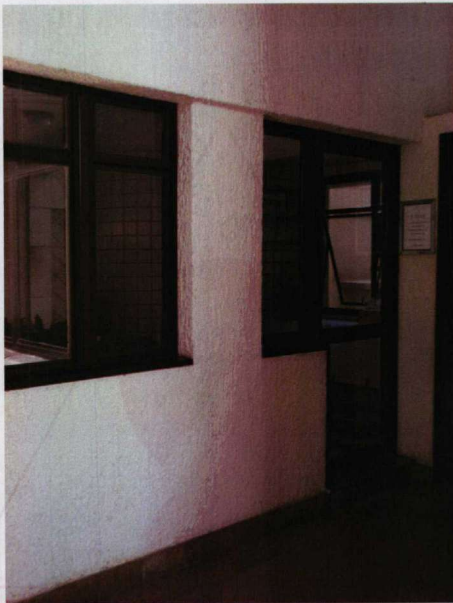
FOTO 16: PORTARIA NO PAVIMENTO TÉRREO DO EDIFÍCIO.
