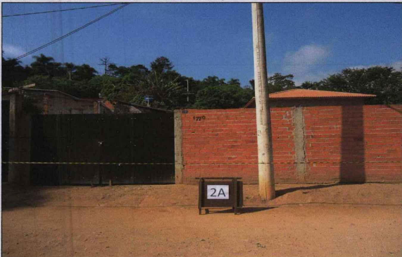
Foto 02 – Lote 2A da rua Pindorama nº 1770
