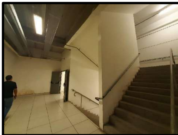
FOTO 18 - HALL DE ESCADAS
