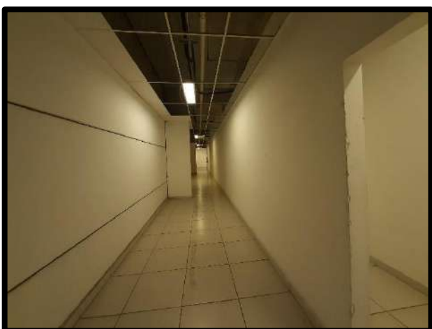
FOTO 19 - CORREDOR DE ACESSO ÀS SALAS DO 2º PAVIMENTO
