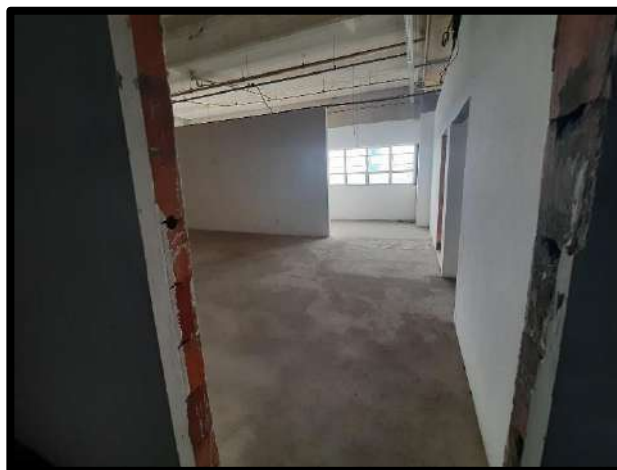
FOTO 26 - SALAS DO 4º PAVIMENTO
