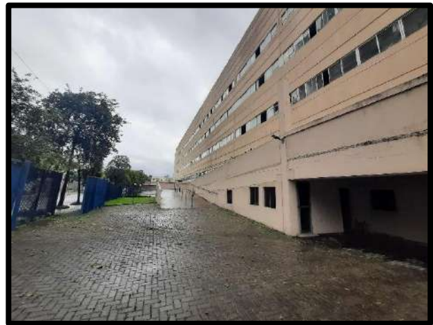
FOTO 12 - FACHADA DO IMÓVEL
