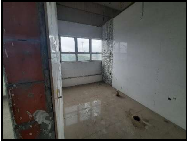
FOTO 27 - BANHEIROS DO 4º PAVIMENTO
