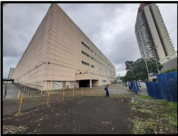
FOTO 11 - FACHADA DO IMÓVEL
