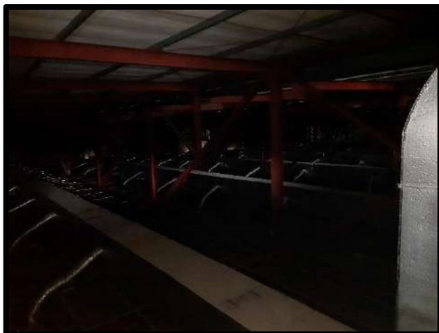
FOTO 42 - VIGAS E SISTEMA DE AR CONDICIONADO
