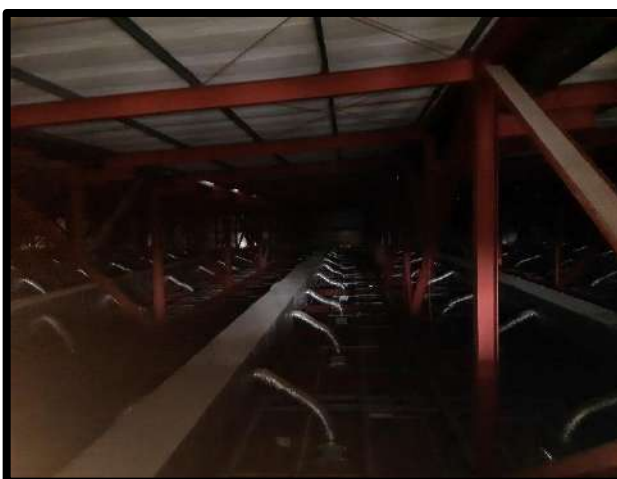
FOTO 40 - VIGAS E SISTEMA DE AR CONDICIONADO
