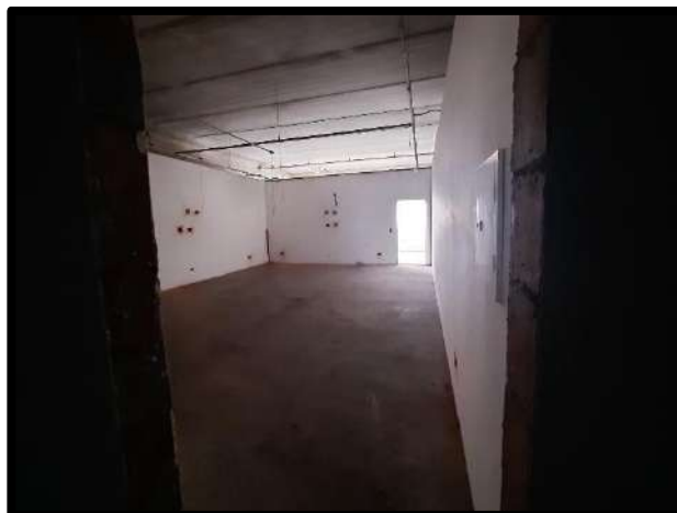
FOTO 22 - SALAS DO 3º PAVIMENTO
