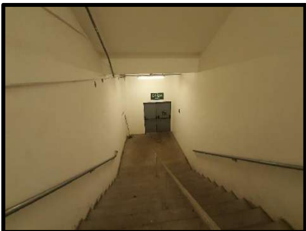
FOTO 15 - ESCADAS DE CIRCULÇÃO
