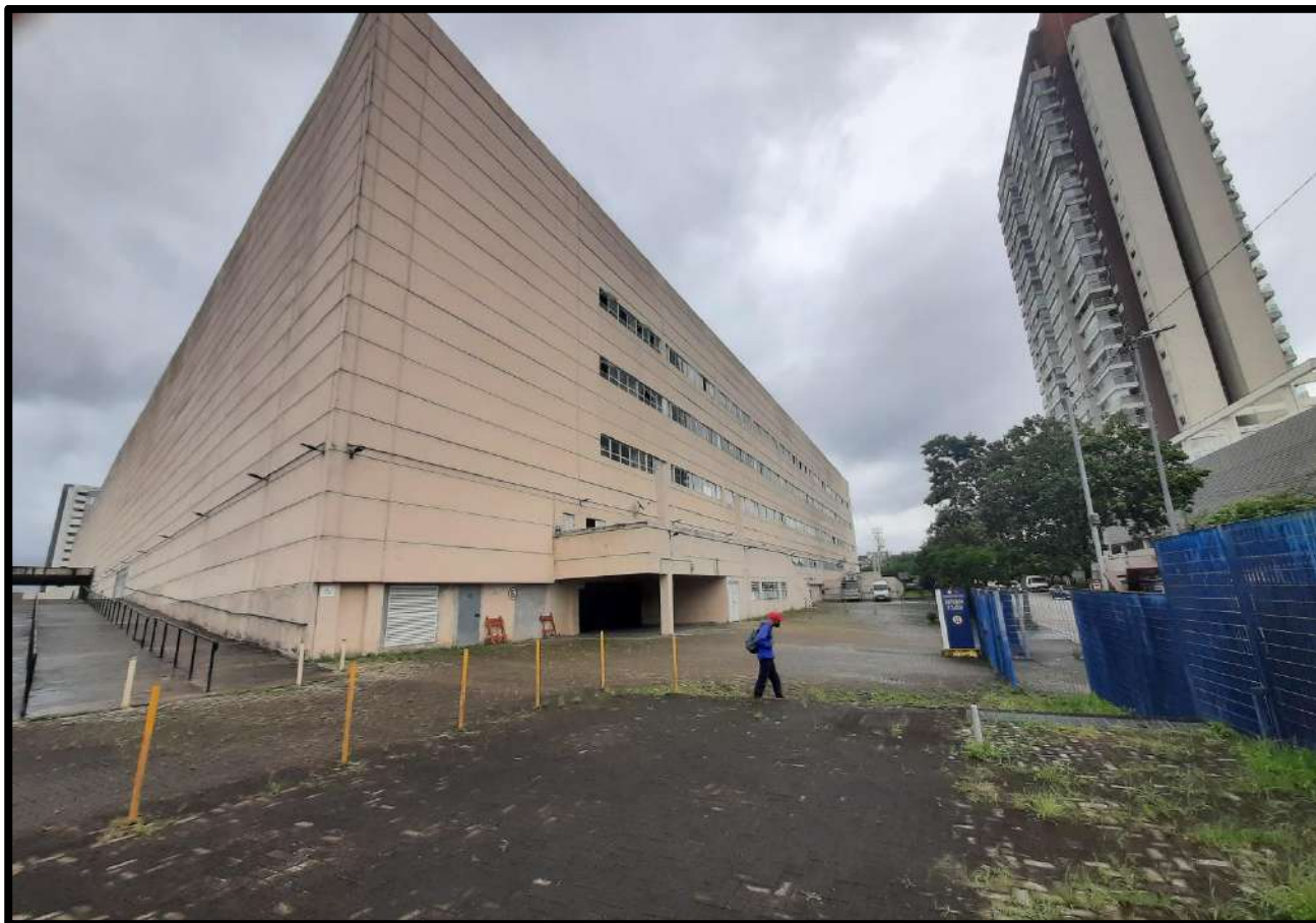
FOTO 1 - FACHADA DO IMÓVEL
