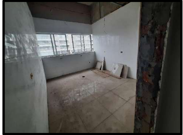
FOTO 28 - BANHEIROS DO 4º PAVIMENTO
