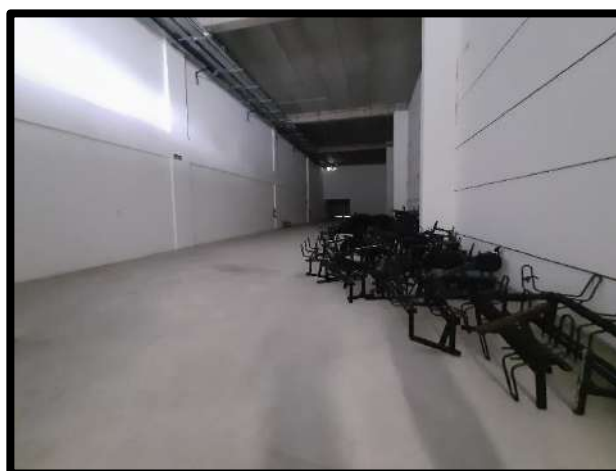
FOTO 20 - SALAS DO 2º PAVIMENTO
