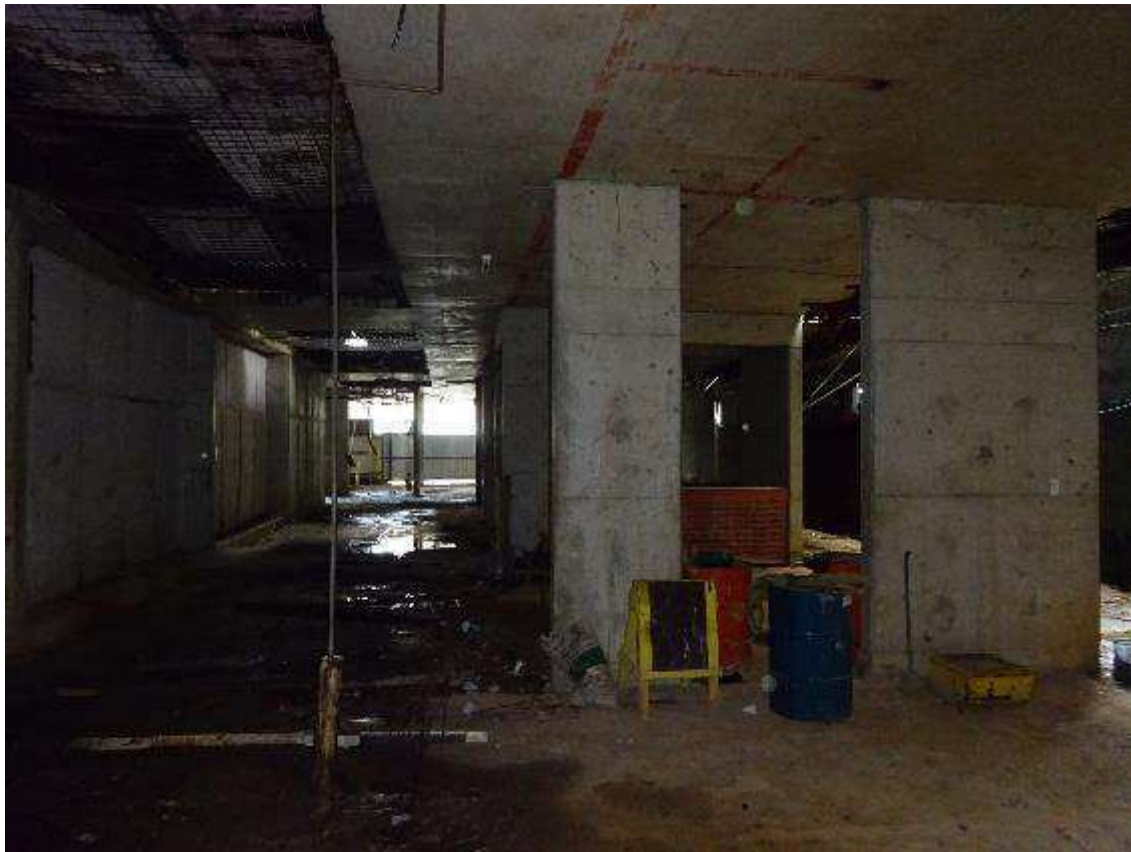
FOTO 3: Vista do interior do Edifício.
