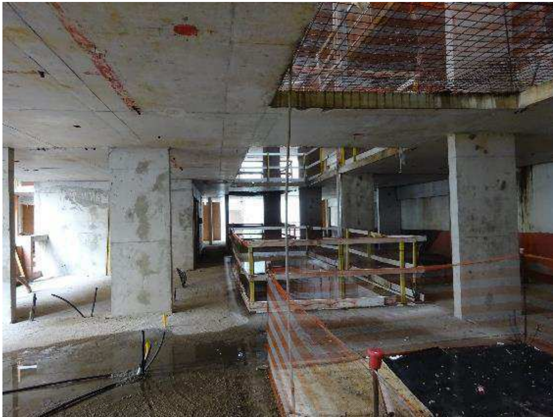
FOTO 5: Nova vista do interior do Edifício.
