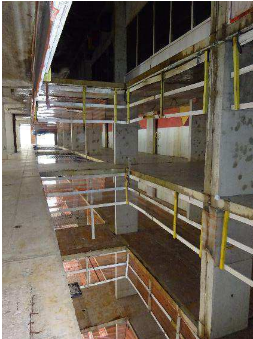
FOTO 4: Nova vista do interior do Edifício.
