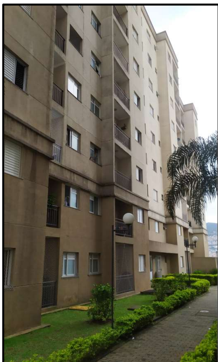
Foto 14: Edifício Belvedere – bloco “A”
