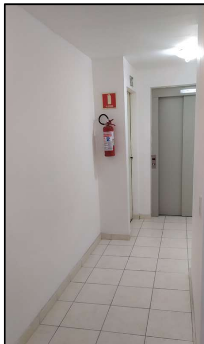
Foto 15: Bloco “A” – Hall de elevadores do 5º andar
