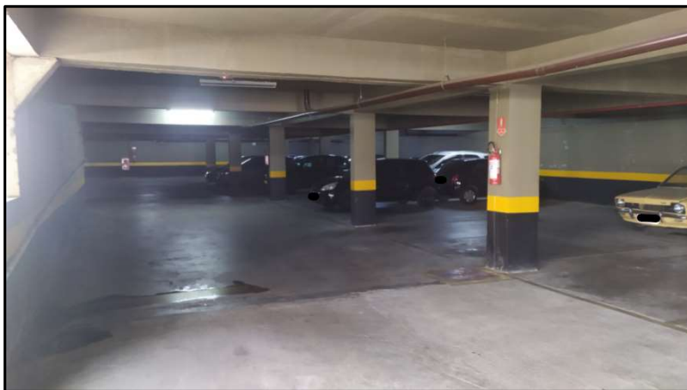
Foto 4: Condomínio Vivere City Jaraguá Residencial Clube – Edifício Garagem – pavimento inferior
