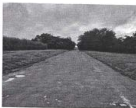
ESTRADA VICINAL ENTRE A MT- 358 E USINA ITAMARATI
