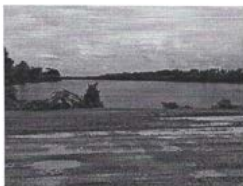
RÉPRESA DO CÓRREGO SÃO LOURENÇO – DIVISA LESTE
