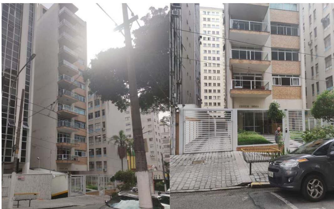
Imagem 1 - Vista da Fachada do Condomínio Edifício Indaia
