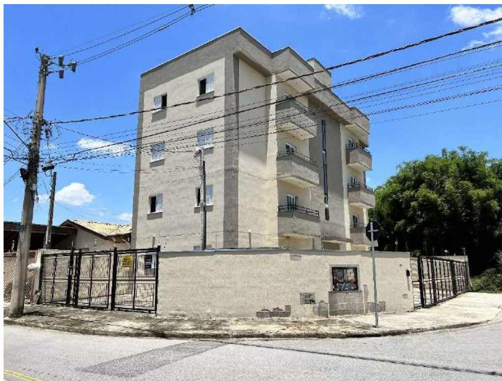
Aspectos gerais do imóvel ATUALMENTE – construído prédio residencial
