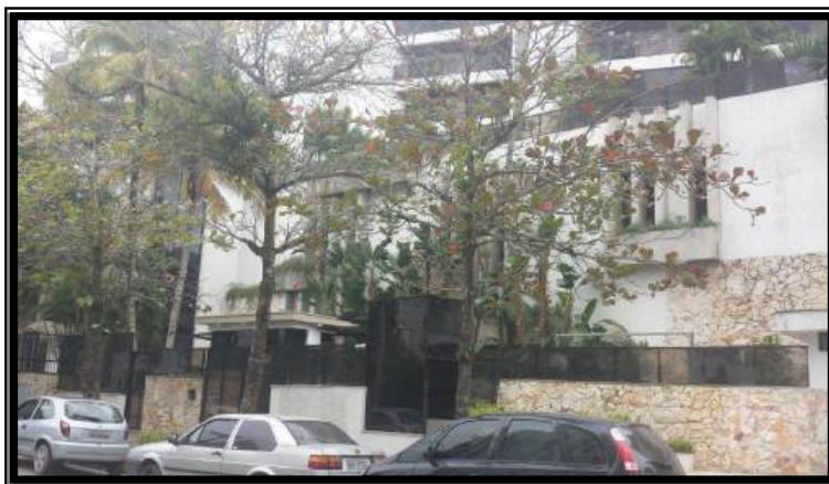
Figura 4 - Entrada do Condomínio
