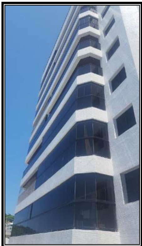
Figura 7 - Vista frontal do edifício
