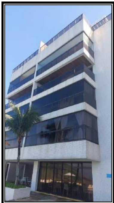
Figura 6 - Vista frontal do edifício
