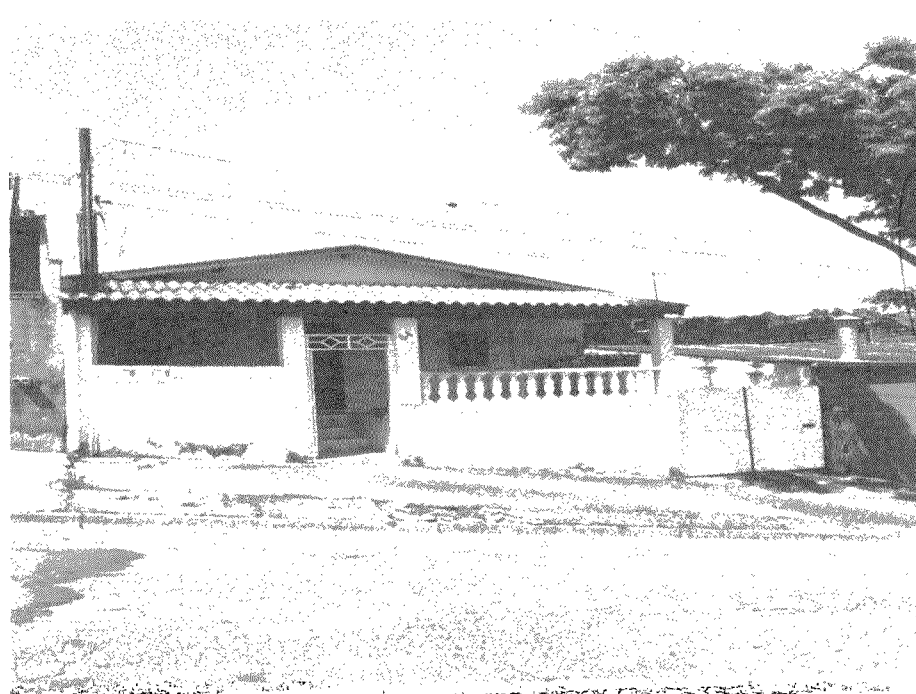
Vista da rua e da fachada do imóvel.
