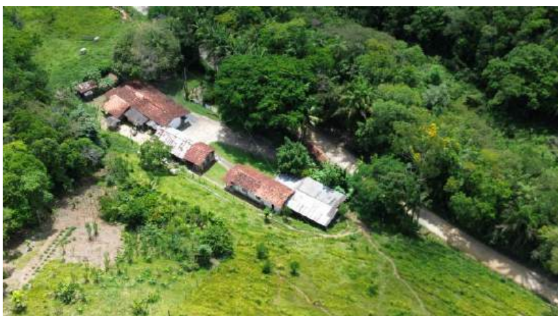
Construções civis do imóvel
